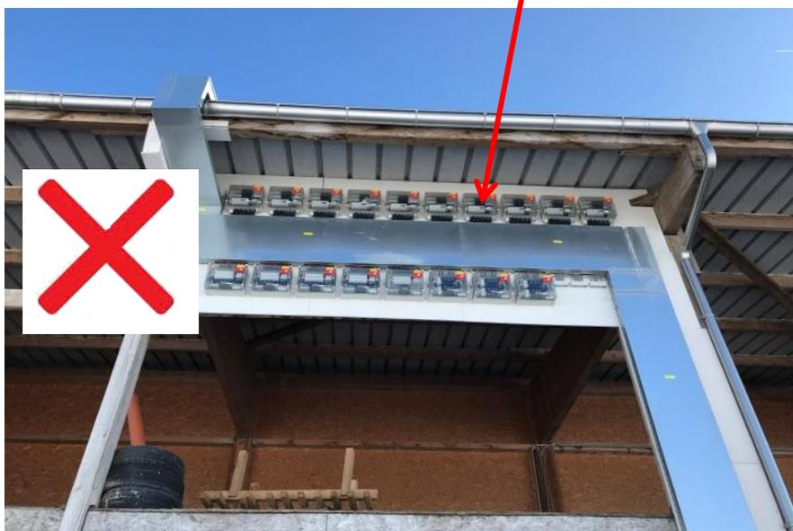
4.9 La distance entre la ligne à protéger par le parafoudre et la terre du parafoudre doit être le plus court possible (si possible < 0.5m).
