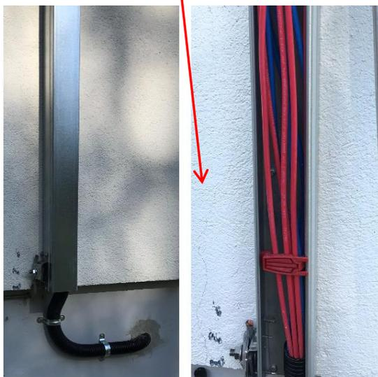
Canal Lanz à trous à l'extérieur du rural, Fermacell contre les parties combustibles.
