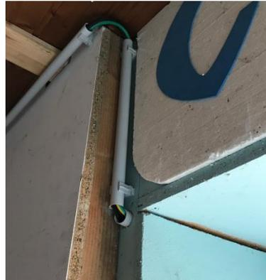
3.4 Attention, lors de la pose de ce type de conduite sur du bois, il faut distancer celle-ci de la paroi d'au moins 1cm ou intercaler un élément incombustible. Par exemple tube alu sur collier ou Fermacell entre canal et façade en bois.
