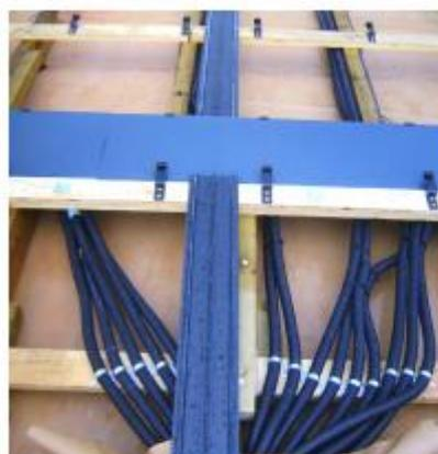
Lignes montantes DC sous tubes de protection difficilement inflammables RF1/RF2 d'une installation intégrée au bâti
