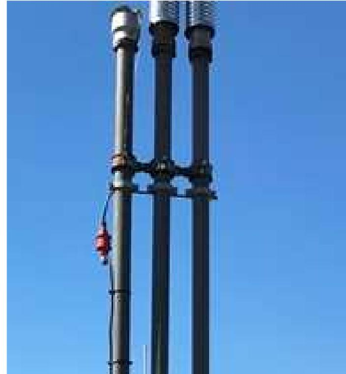
Conduites de compensation de citernes d'une station service, la cuivre nu est plaqué contre la conduite avec des attaches plastiques avant la liaison au parasurtension...
