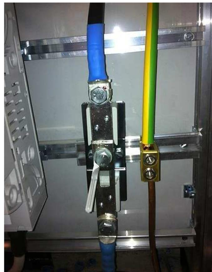
Pas de liaison entre le PEN du réseau et la borne de PE (Sectionneur N standard)
