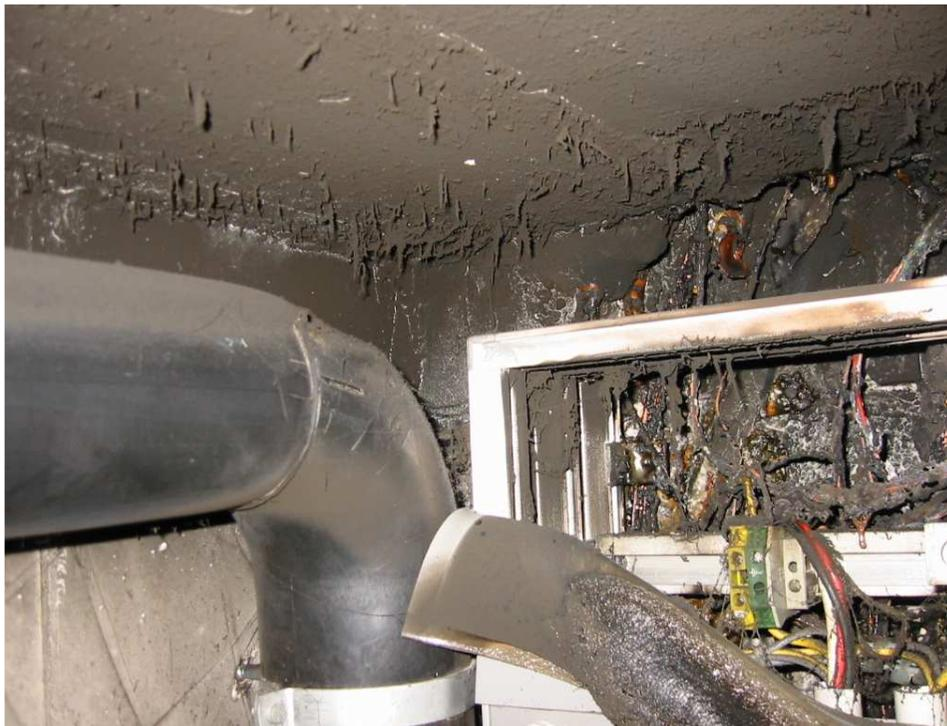
Le tuyau Geberit a également été déformé à la même hauteur que le haut du cadre ainsi que les tubes et les câbles fondus jusque dans la dalle
