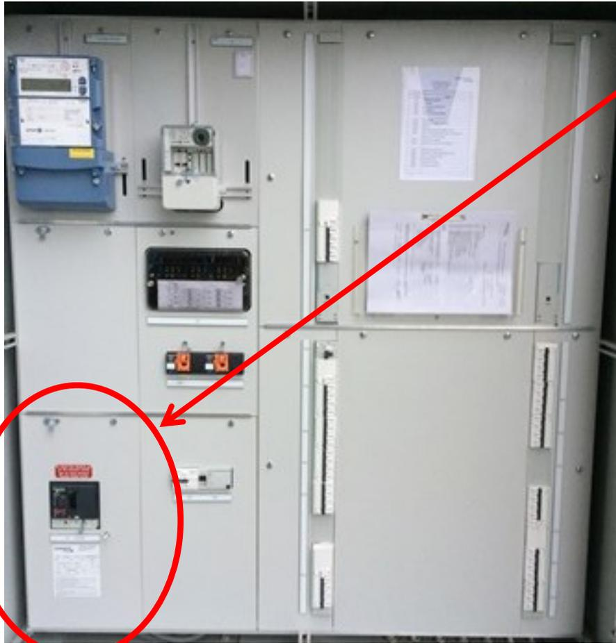
Si une plaque indépendante protège uniquement les bornes d'alimentation, les autres plaques seront enlevées séparément, il n'y a pas de protection supplémentaire nécessaire sur les parties sous tension.
